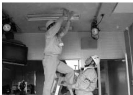
天井の吹きつけ材調査の様子
