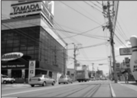
工事起点付近
