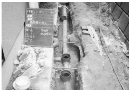
排水工事の様子(上阿志岐西区)
