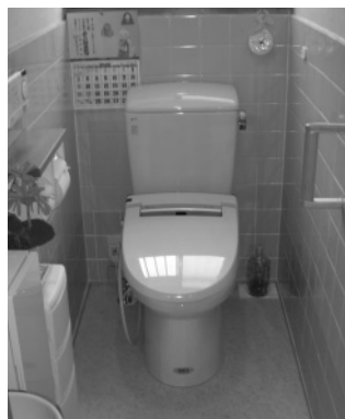
水洗化工事(改造後)
