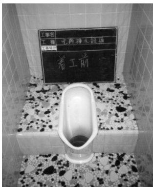
水洗化工事(改造前)
