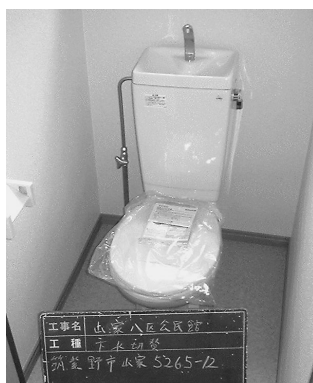
水洗化工事（改造後）
