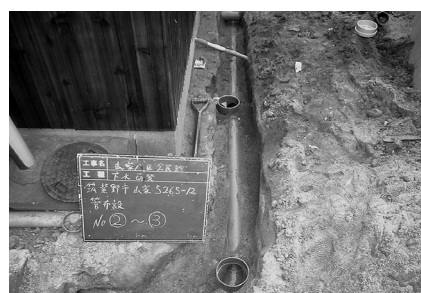
排水工事の様子（山家8区）
