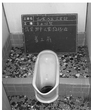
水洗化工事（改造前）
