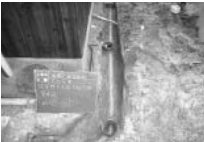
排水工事の様子(山家8区)
