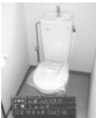
水洗化工事(改造後)
