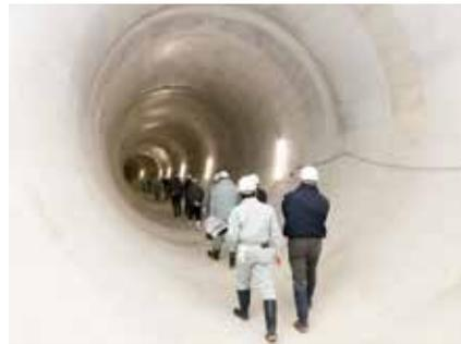
▲二次覆工が完了したトンネル内部
