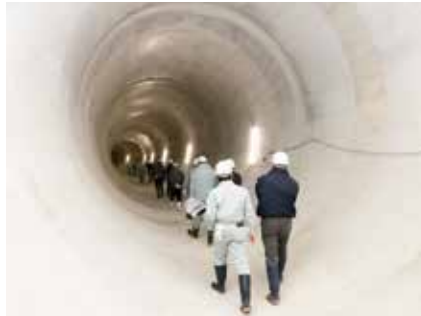
▲二次覆工が完了したトンネル内部
