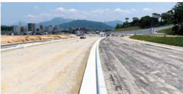
▲筑紫駅方面と美しが丘北をつなぐ筑紫原田線
