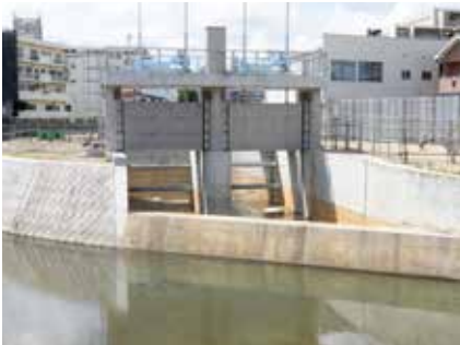
▲トンネルを通過して河川に合流する流出施設
