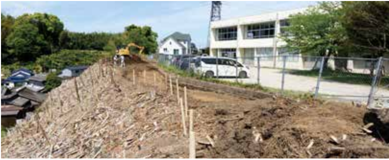
▲工事のため、樹木を伐採した筑紫小南側の斜面
