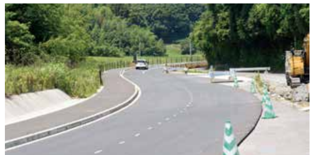
▲工事が進む県道山口原田線(原田から城山方面)
