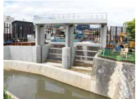
▲高尾川からの流入施設
