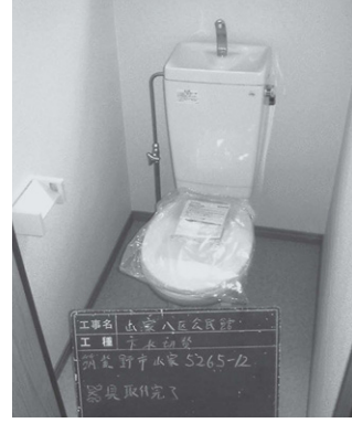
水洗化工事(改造後)
