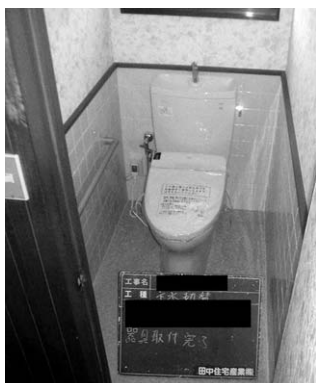
水洗化工事(改造後)
