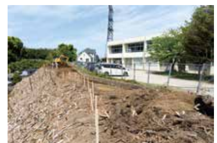
筑紫小学校下の急傾斜地崩壊を防止する措置を進めています
