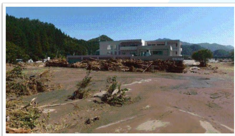
平成28年台風第10号による被害状況
