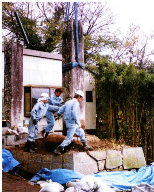
▲解体中の国境石
