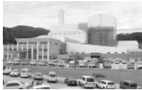
建設が進む宝満環境センター新規施設
